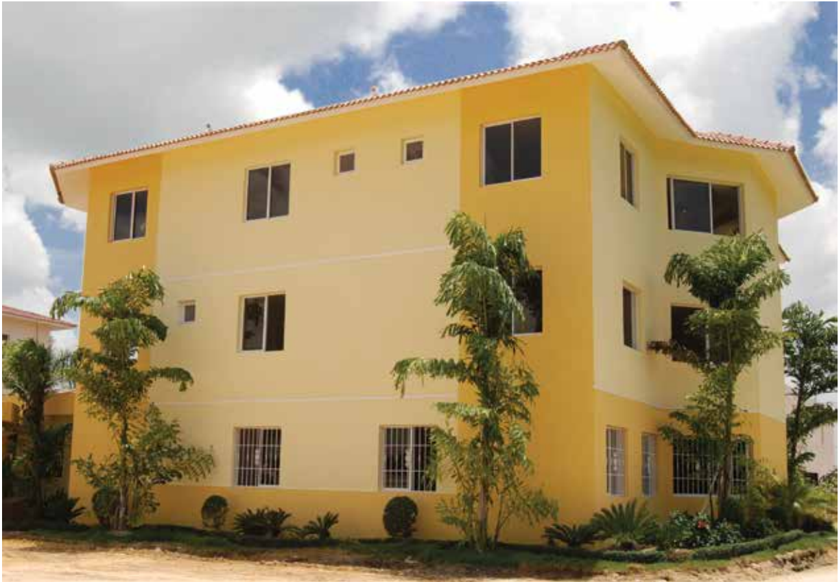
Edificio de Administración del Centro de Formación Integral Juventud y Familia, carretera Juan Pablo II, Santo Domingo, agosto 2012.
