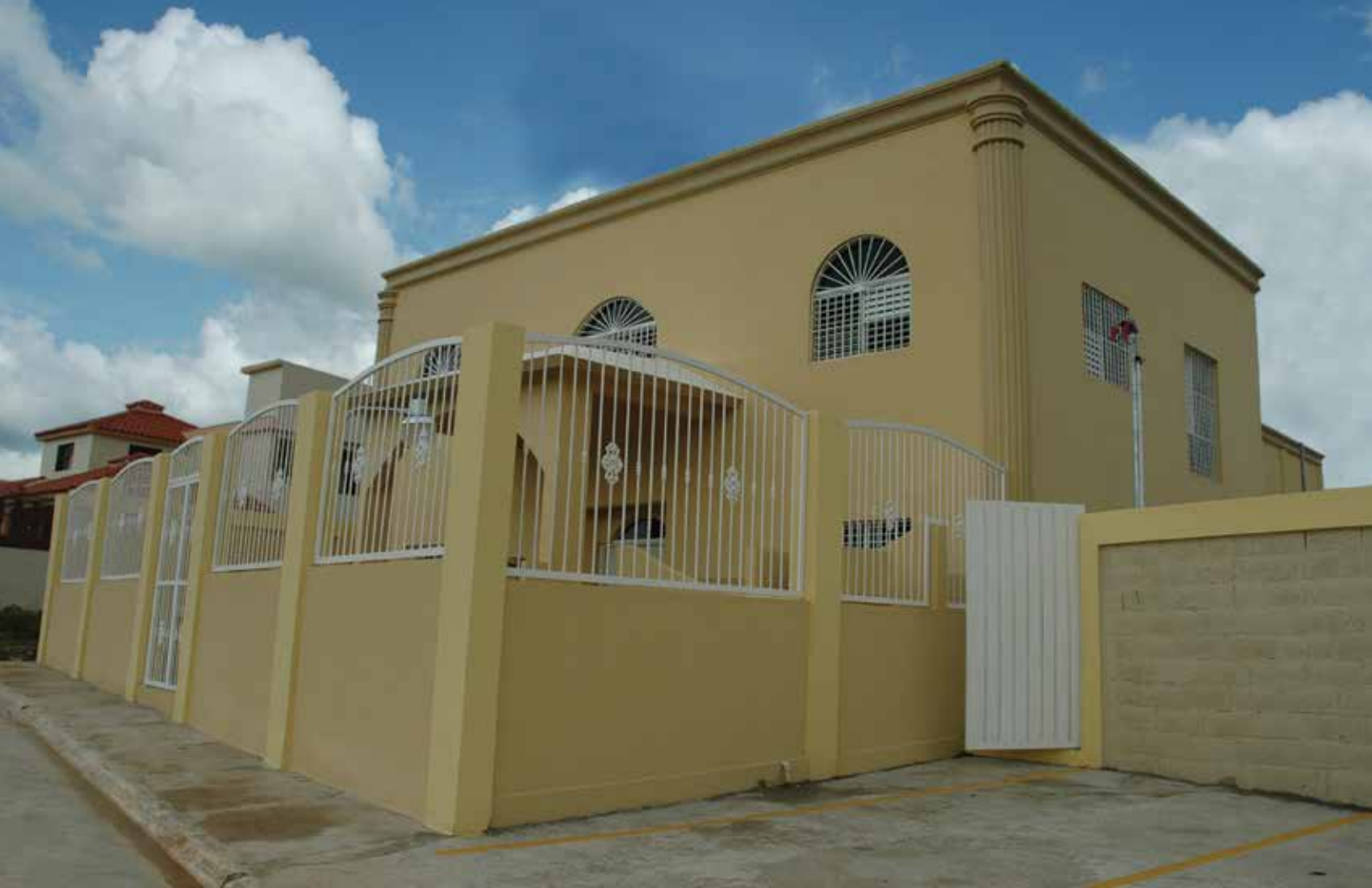
Fachada principal de la Casa de Estudio del Padre Abel, en el sector Vista al Valle de la Provincia Duarte, 18 de julio de 2008.
