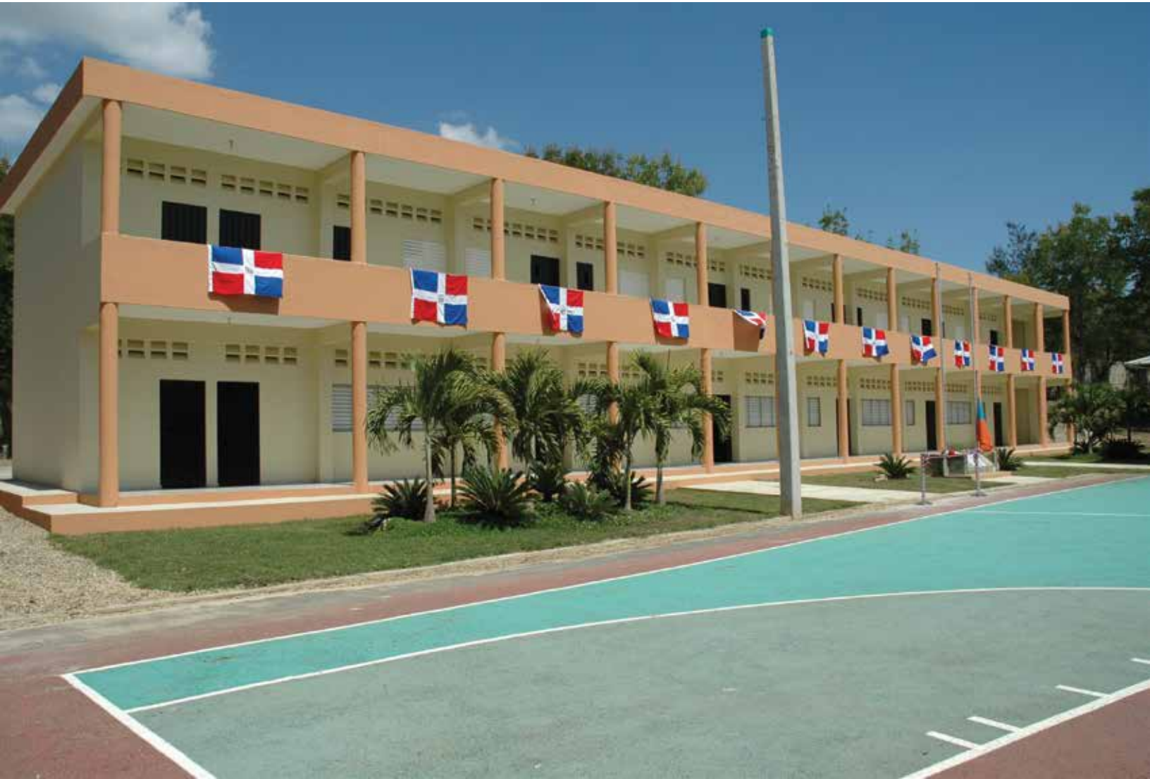
Edificio de Aulas para el Instituto Politécnico Industrial de Santiago, 2007.
