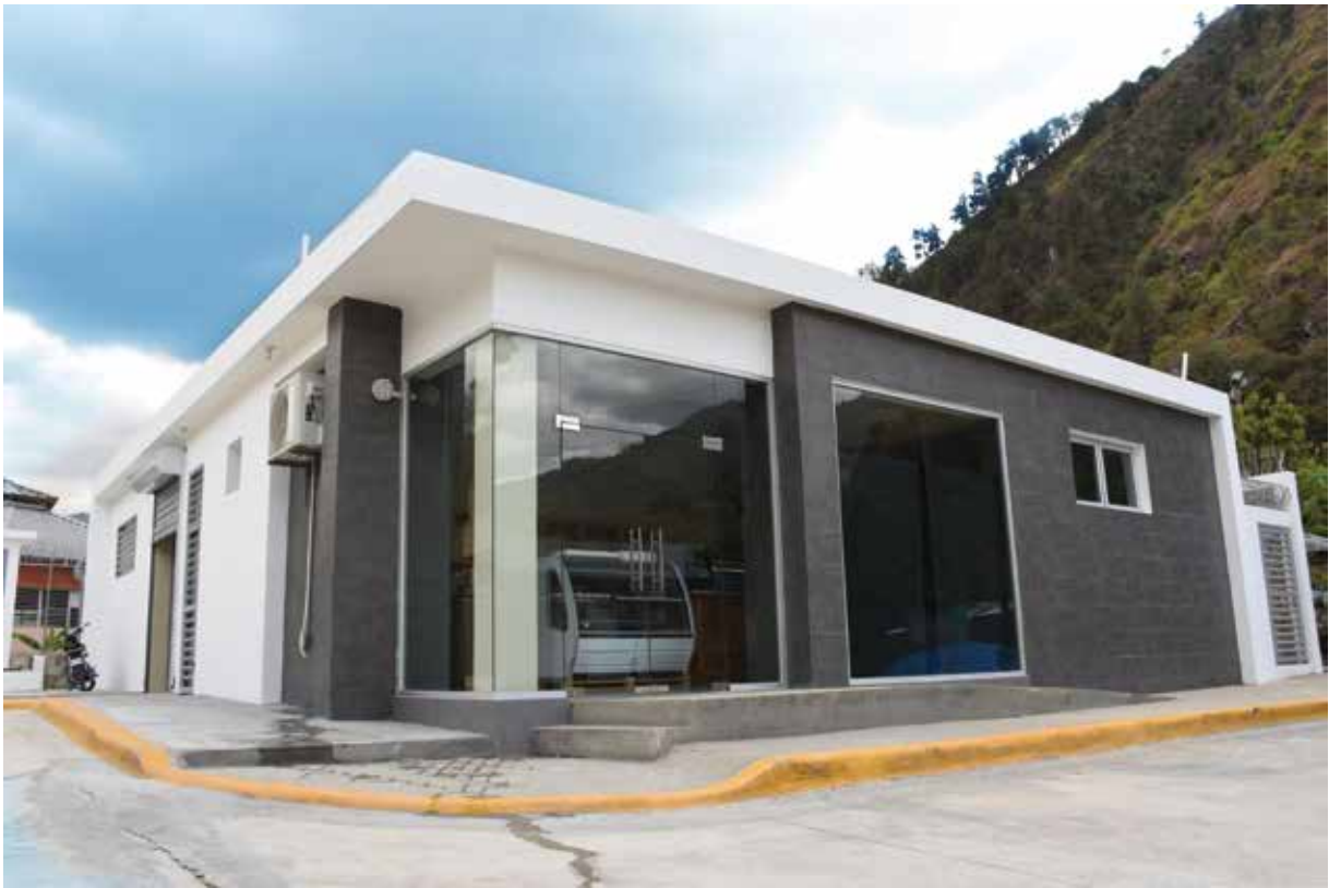
Fachada de la panadería-repostería en Guayabal, provincia Azua, 2019.
