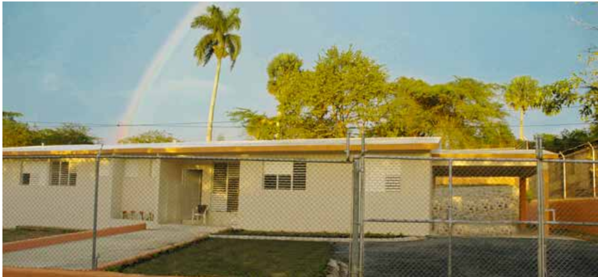
Fachada principal de la Clínica Rural Palo Amarillo, provincia Santiago de los Caballeros, inaugurada 11 de agosto de 2008.
