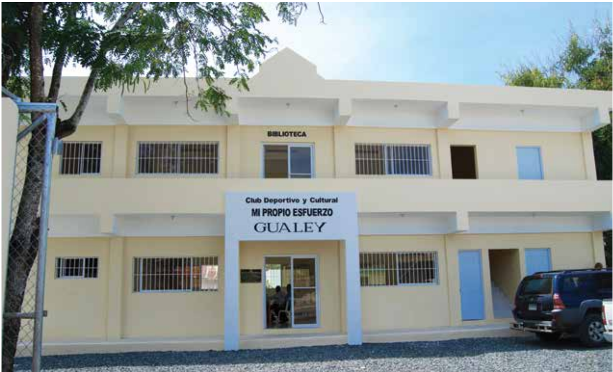
Salón Multiusos y Biblioteca en el Sector Gualey, provincia Hato Mayor, 7 de septiembre de 2011.
