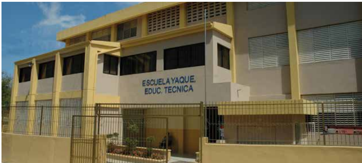
Fachada de la Escuela Yaque Educación Técnica intervenida por el FONPER por ser afectada por las tormentas Noel y Olga, Zona Sur de Santiago de los Caballeros, entregada 7 de marzo de 2008.
