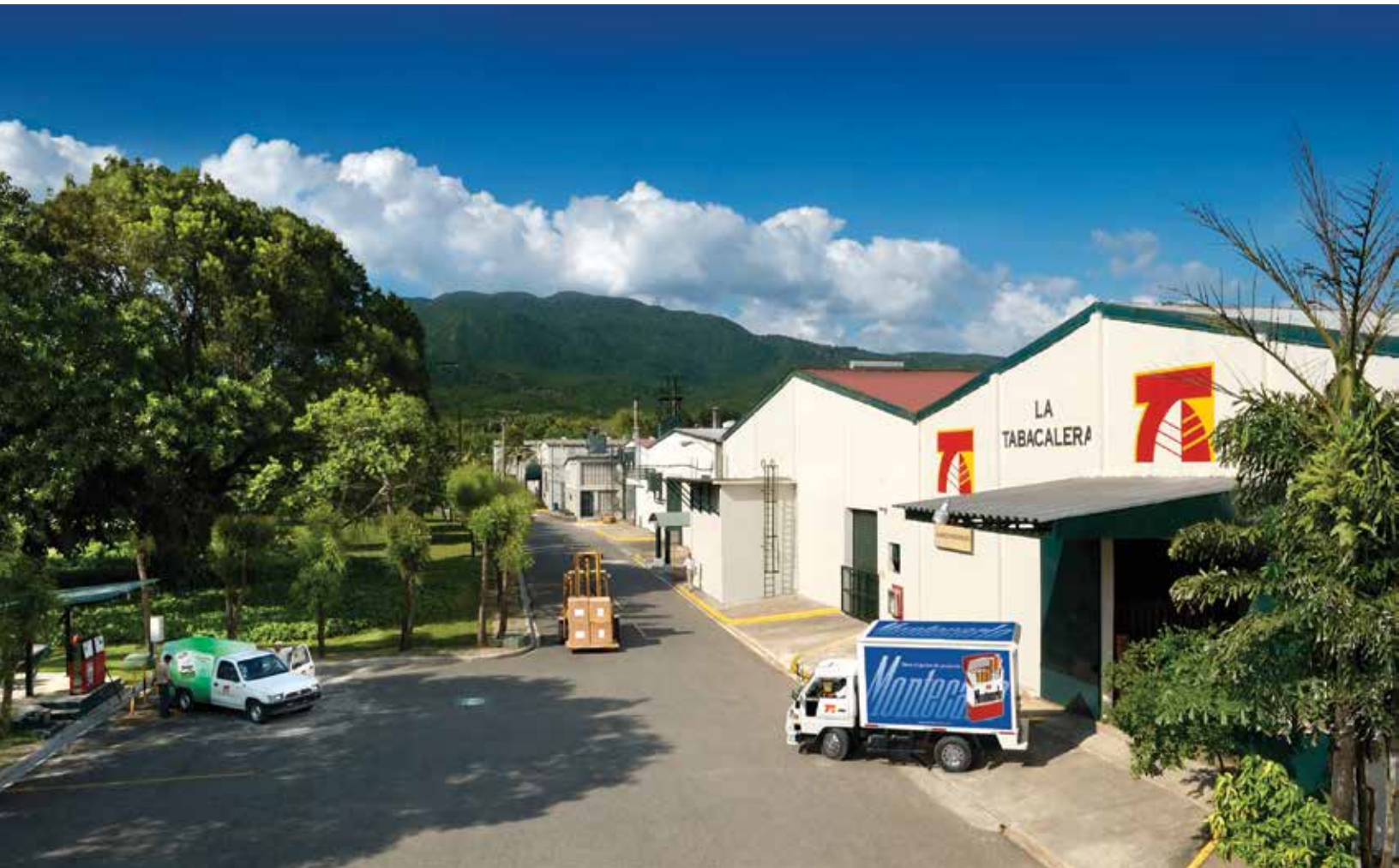
Naves industriales de La Tabacalera. Provincia de Santiago.
