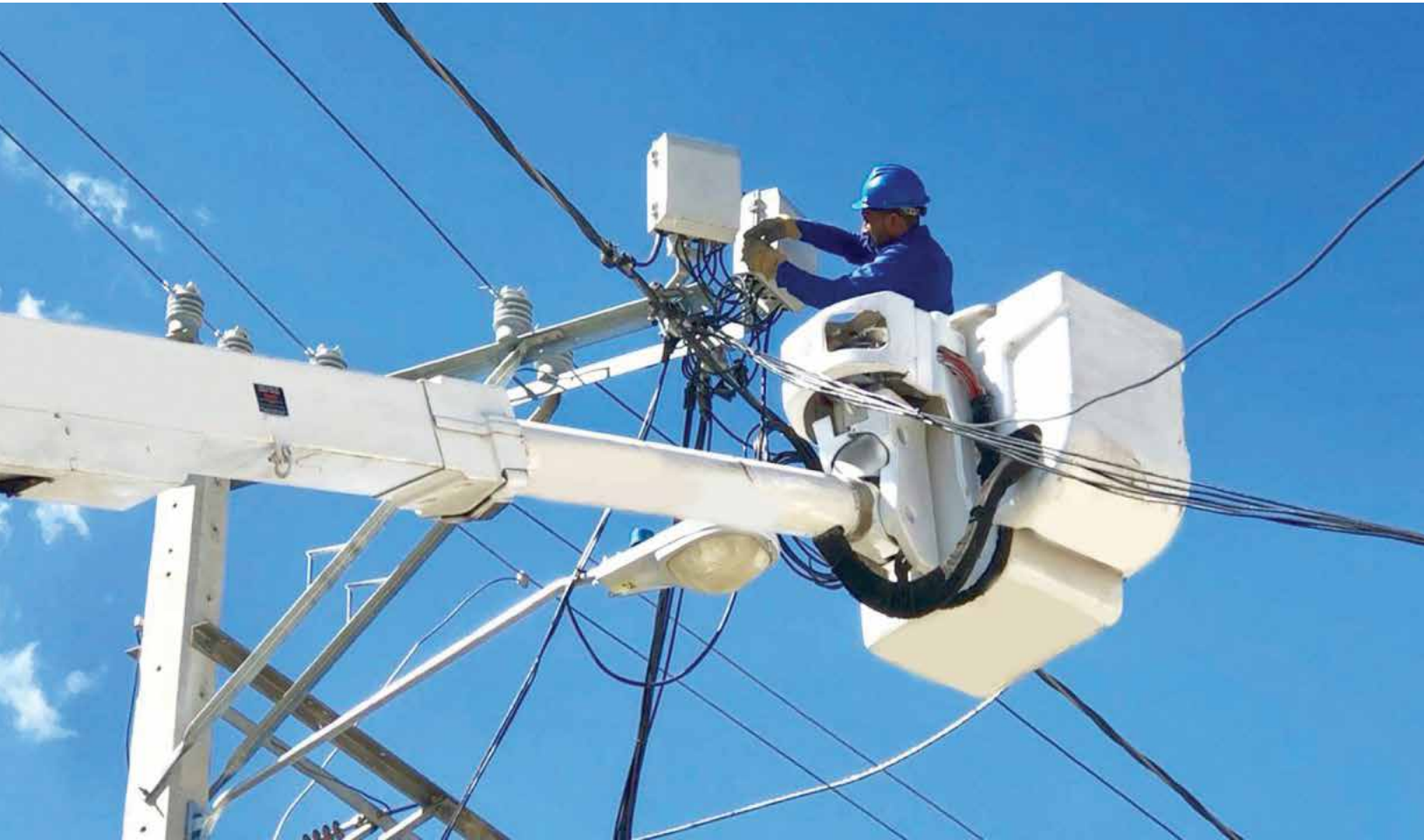
Operario de EDESUR manipula tendido eléctrico.
