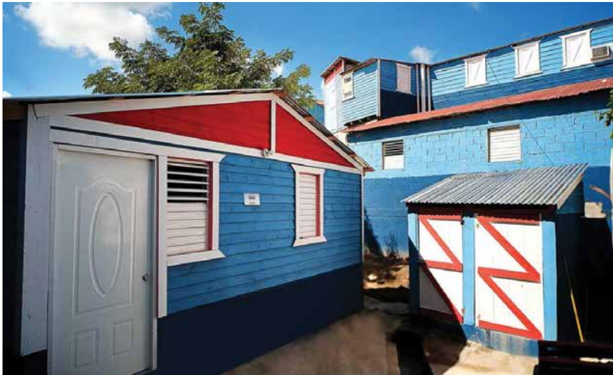
Viviendas en el sector El Ejido, provincia Santiago, construidas por el Instituto Nacional de la Vivienda – INVI a través de un acuerdo interinstitucional con el FONPER, 2018.
